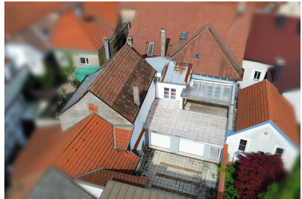
Ansicht Terrasse und Hof
